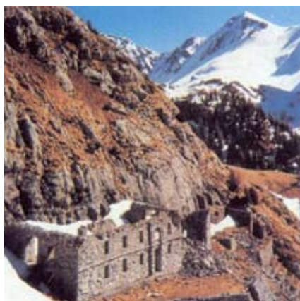
Pal Grande di Sopra - la stupenda costruzione in pietra lavorata del ricovero del Btg. “Tolmezzo”. Il fabbricato, agibile fino nel 1940, veniva usufruito dagli alpini durante le esercitazioni estive.
