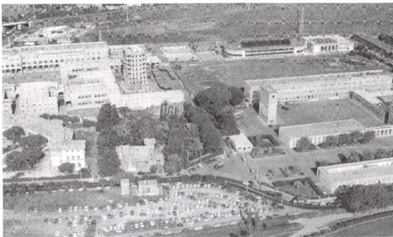
Roma. Una veduta aerea della Scuola Centrale Antincendi
