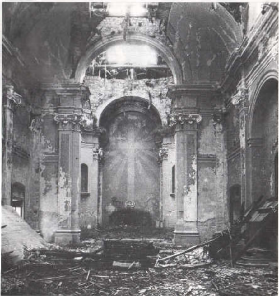
Campeggio di Faedis: interno della Chiesa di San Michele Arcangelo prima dell'inizio dei lavori di ristrutturazione; il grande mosaico del Santo che vogliamo offrire al Nostro Patrono e alla nostra devozione occuperà l'intera abside.
